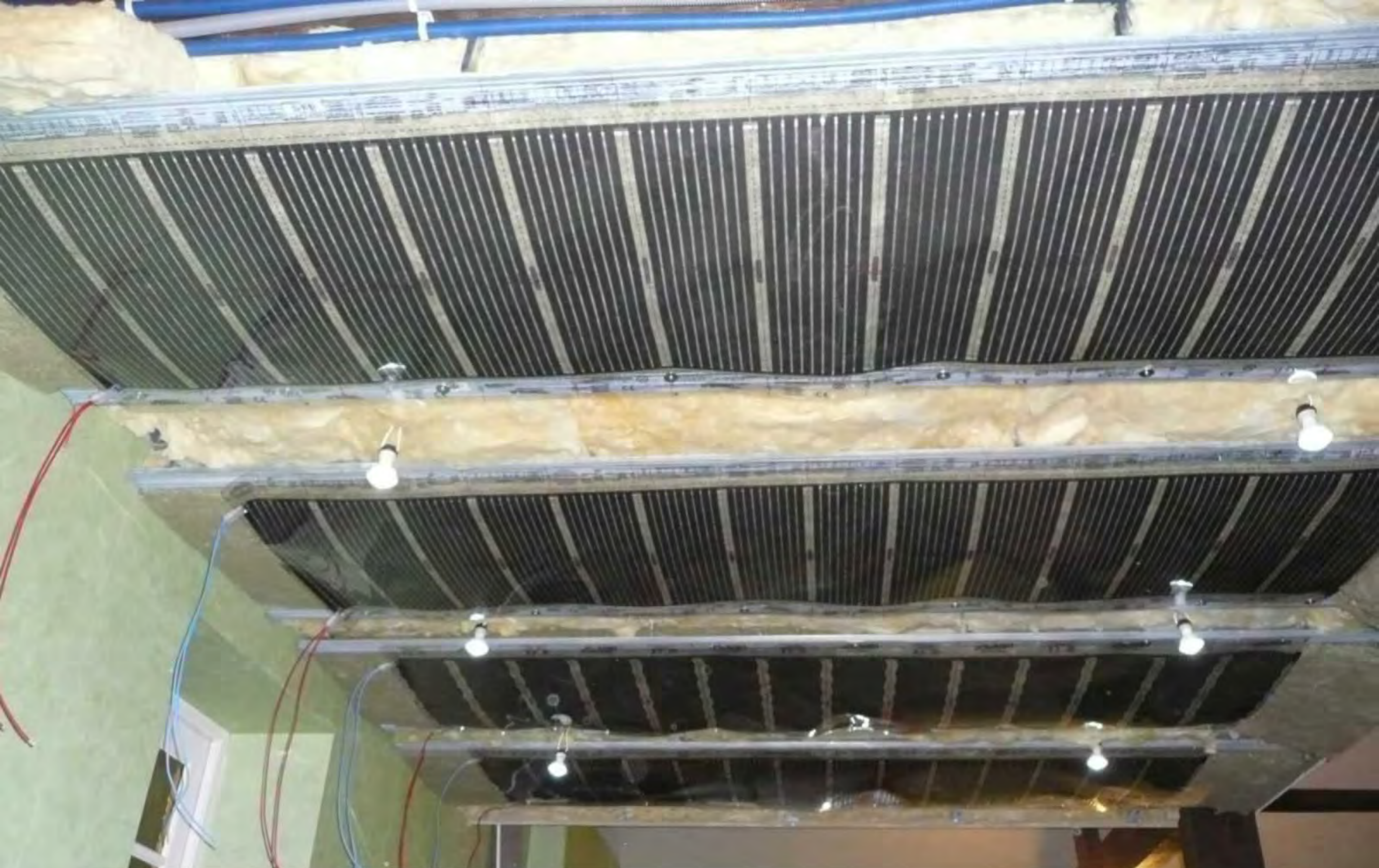
Durant le temps des travaux, il est cependant possible de fixer les films chauffants.
