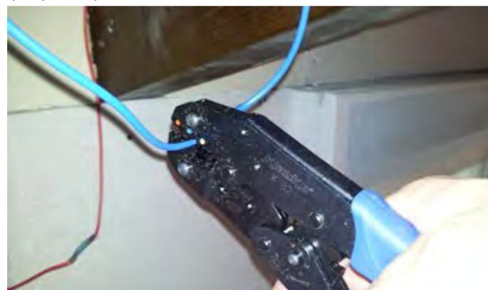
Raccorder électriquement les films et vérifier leur bon fonctionnement à l'aide d'un ohm-mètre ou d'un laser thermique.
