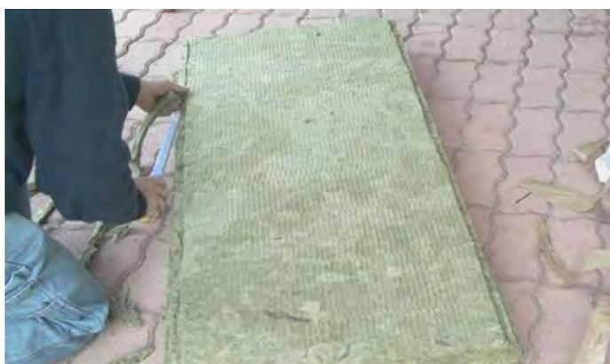
A l'aide d'un cutter ou d'un couteau pour laine minérale, réaliser une feuilure des deux côtés de l'isolant.
