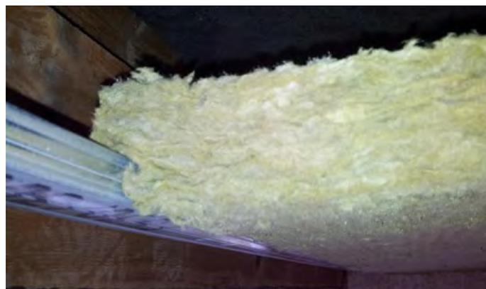
L'isolant feuiluré se trouve au même niveau que la partie basse des fourrures.
