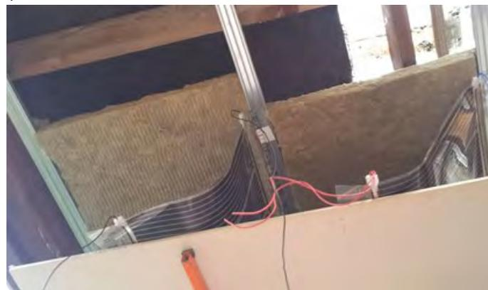
Ménager un espace de dilatation de 6 mm environ entre la plaque de plâtre et les murs.
