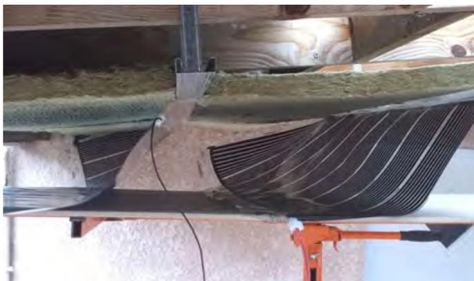
A l'aide d'un lève-plaque, monter la plaque de plâtre tout en veillant au bon positionnement du film.
