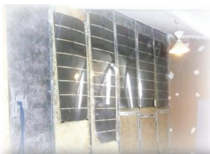
Le film chauffant est scotché ou agrafé sur la structure porteuse, pris en sandwich entre l'isolant et le parement décoratif. Applications : plaque de plâtre, lambris, miroir, marbre...
