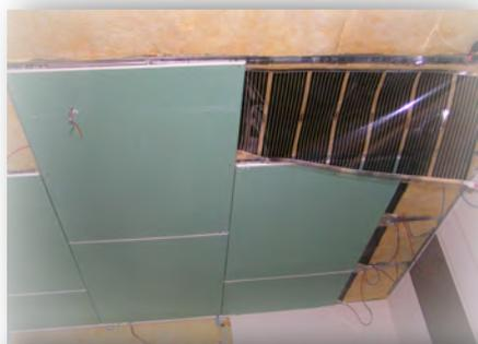
Un isolant en laine minérale avec épaulements latéraux est placé en appui sur les fourrures. Le film chauffant est directement fixé en sous-face de la structure, au contact de l'isolant. Applications : plaque de plâtre ou lambris.
