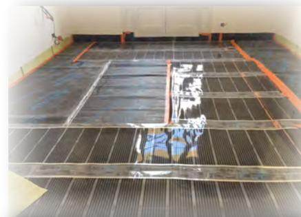
Le film chauffant est posé sur un isolant mince réflecteur, puis recouvert d'un film plastique étanche. Applications : Parquet flottant, carrelage, PVC, moquette...
