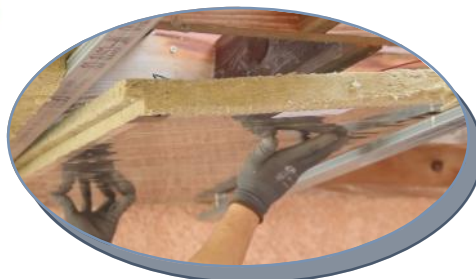
Chantier exécuté rapidement
